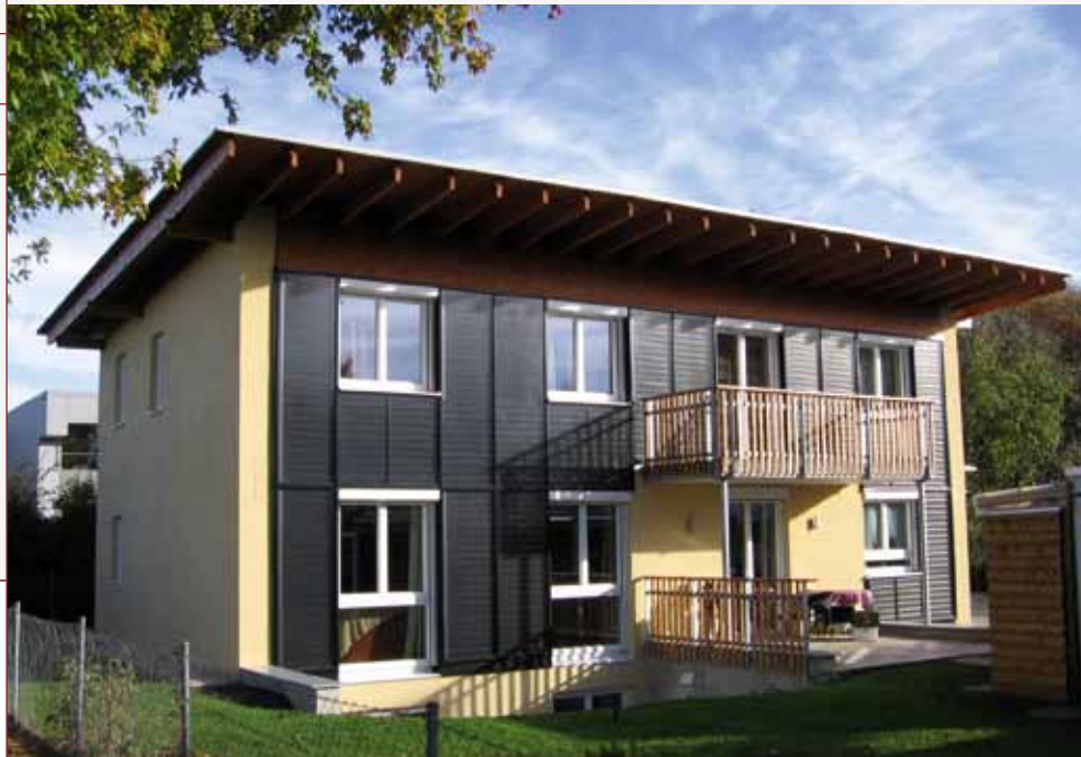
Das Sonnenhaus Binder in Bruckmühl.
