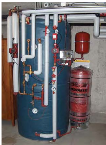
Glaswolle oder Schaumstoff (Brandklasse III oder V) mit Kunststoffhülle
