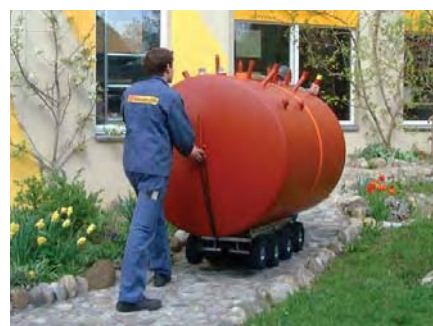
Auf Wunsch: Mithilfe beim Einbringen und Isolieren des Speichers auf der Baustelle
