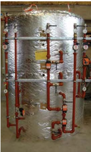
Glaswolle alubeschichtet mit Maschengitter
