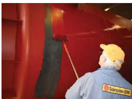
Anbringen der Rostschutzgrundierung
