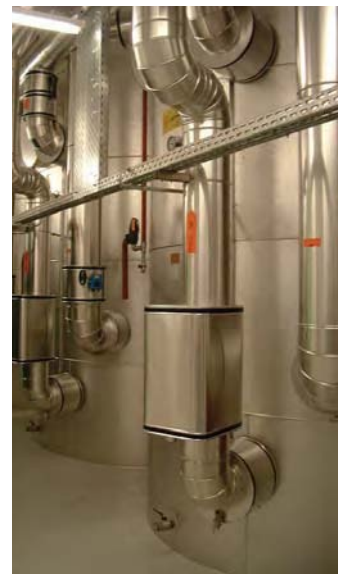
Spezialisolationen (z.B. mit Alumantel oder für Kältespeicher)
