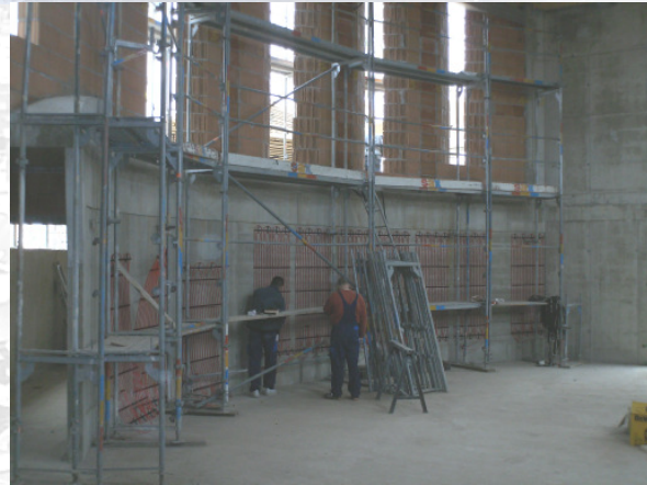
wandheizung als zusatzheizfläche bei fehlender heizlast
